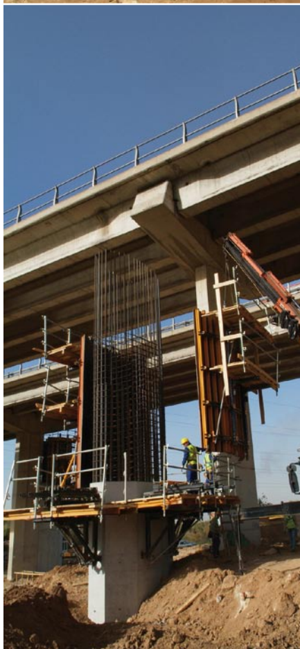
Los equipos de obras trabajan en diferentes puntos de la AP-7 en la colocación de pilares y vigas del nuevo tercer carril.
