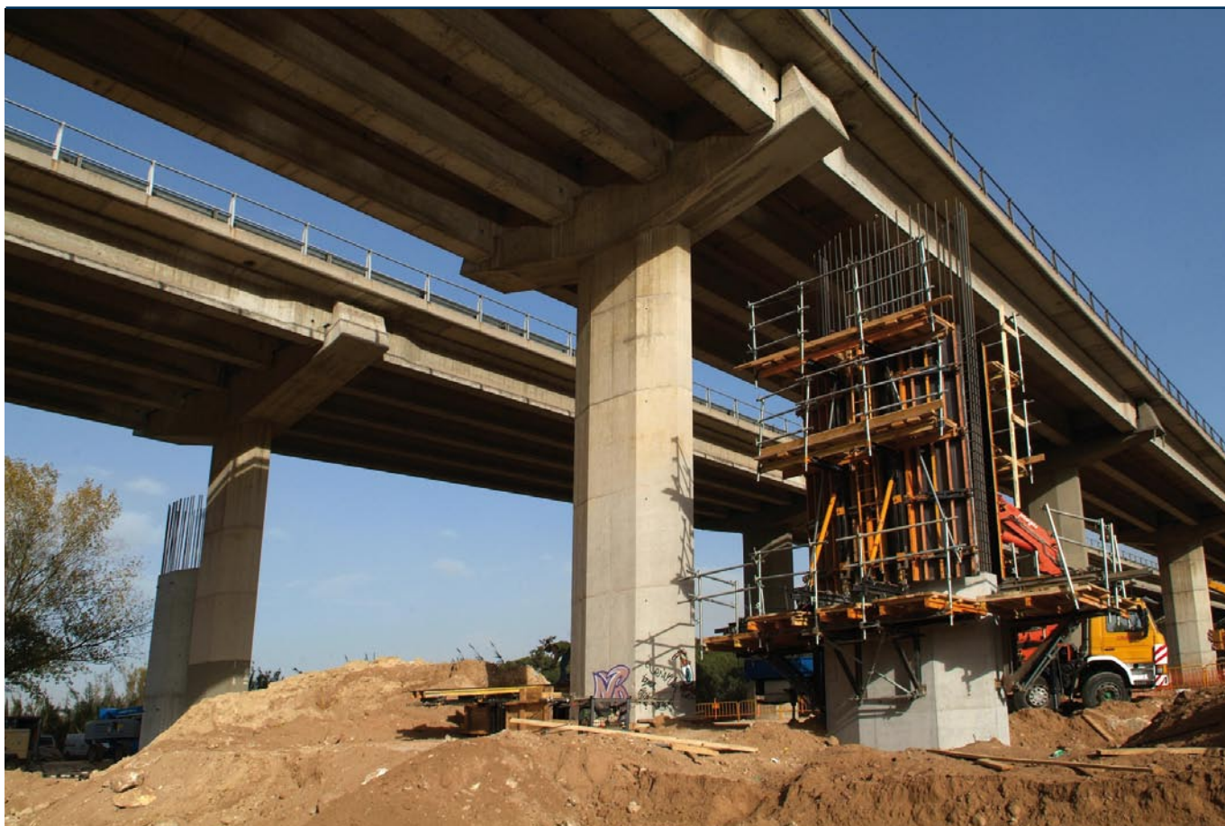
Los equipos de obras trabajan en diferentes puntos de la AP-7 en la colocación de pilares y vigas del nuevo tercer carril.
