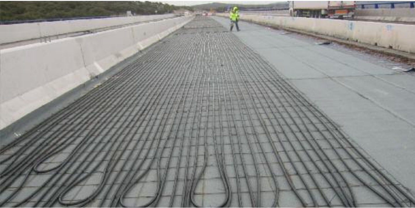
Projecte Geoducto: sistema de calorifugació de taulers de viaductes, basat en energia geotèrmica. Projecte cofinançat amb fons FEDER pel Ministeri d'Economia i Competitivitat dins de la convocatòria INNPACTO 2011 amb número d'expedient IPT-2011-1233-370000.
