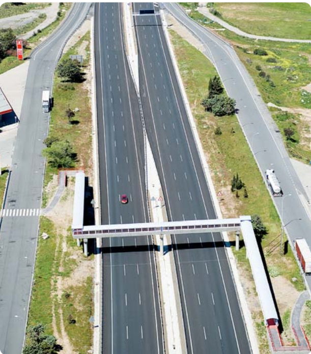
La autopista AP-6 en el entorno del kilómetro 79 a su paso por la localidad de Villacastín.
