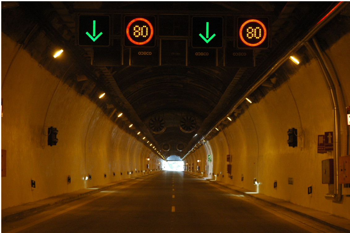
Interior del Túnel I
