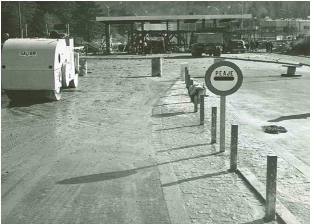
El primer peaje del Túnel de Guadarrama, previamente a su inauguración
